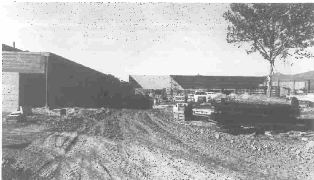
FORNACETTE: Il costruendo CENTRO SOCIALE E COMMERCIALE
