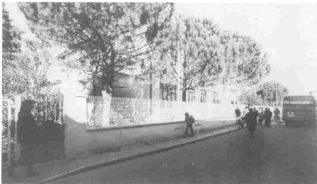
CALCINAIA: La scuola Elementare ristrutturata
