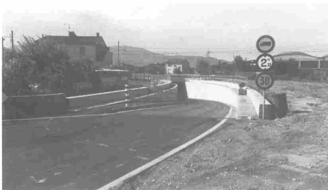
FORNACETTE: Sottovia Via Case Vecchie
