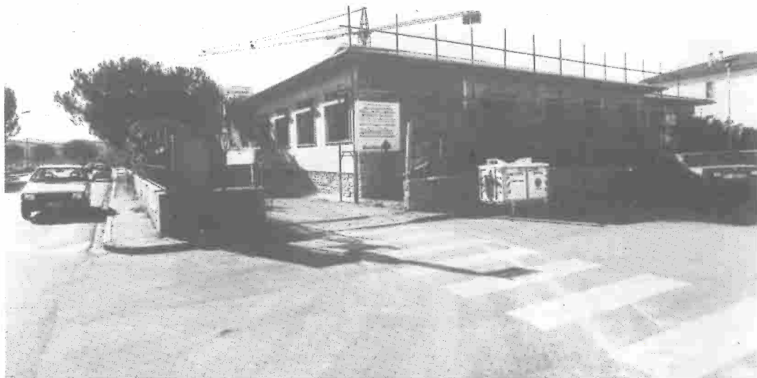
FORNACETTE: Interventi di ristrutturazione alla Scuola Elementare di Via Leopardi
