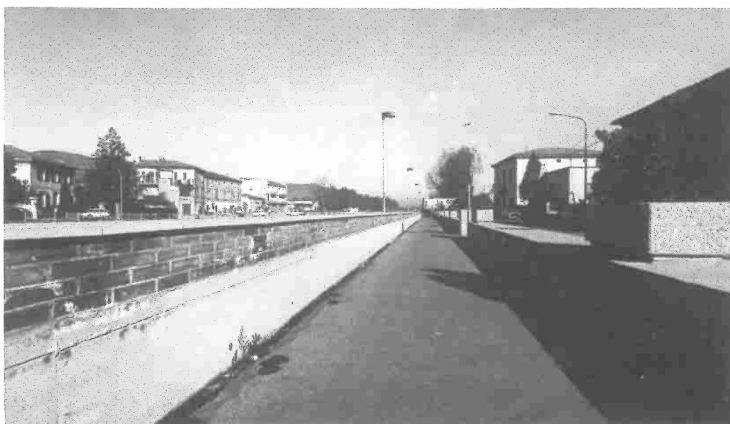
FORNACETTE: Via P. Togliatti - il pedonale/ciclabile
