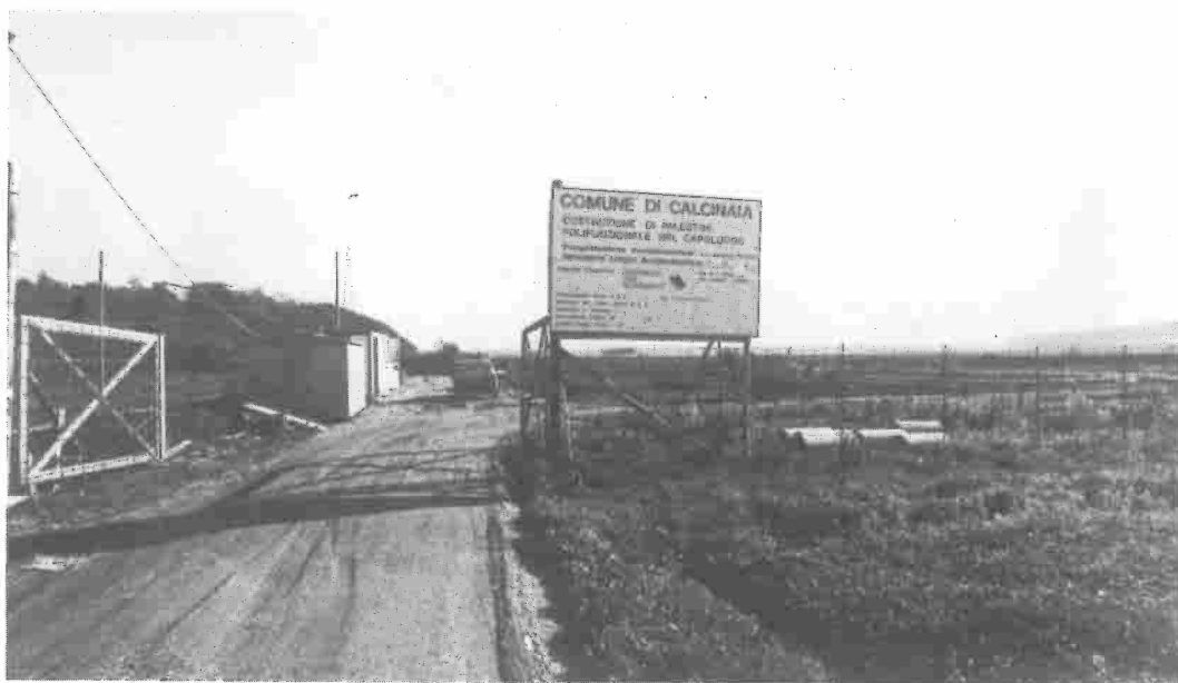
CALCINAIA: ZONA SPORTIVA - Via G. Di Vittorio - Cantiere nuova palestra
