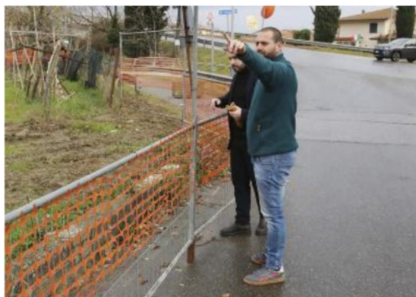
L'apertura del cantiere della pista ciclo-pedonale
