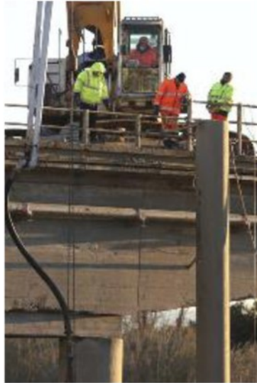
Operai al lavoro sul ponte
