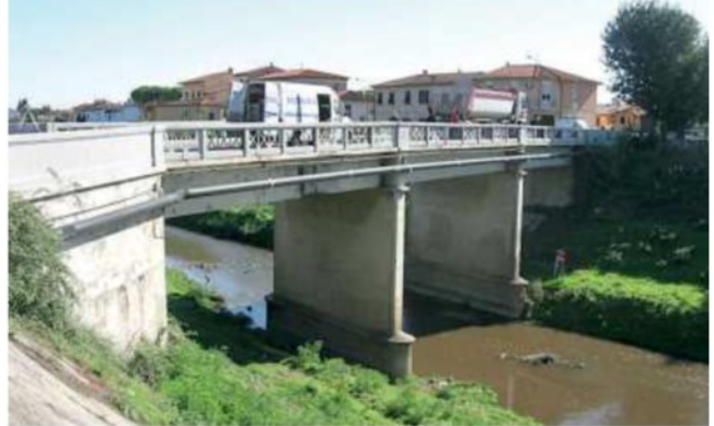
Il ponte sull'Usciana a Montecalvoli
