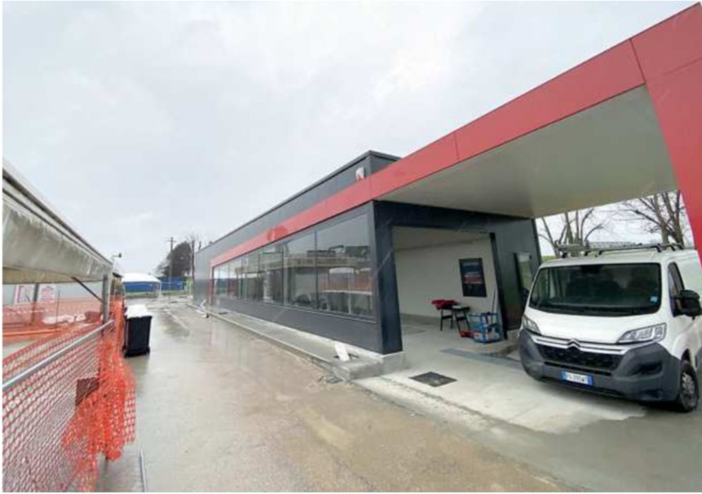
Il nuovo impianto per il lavaggio delle auto a Fornacette
