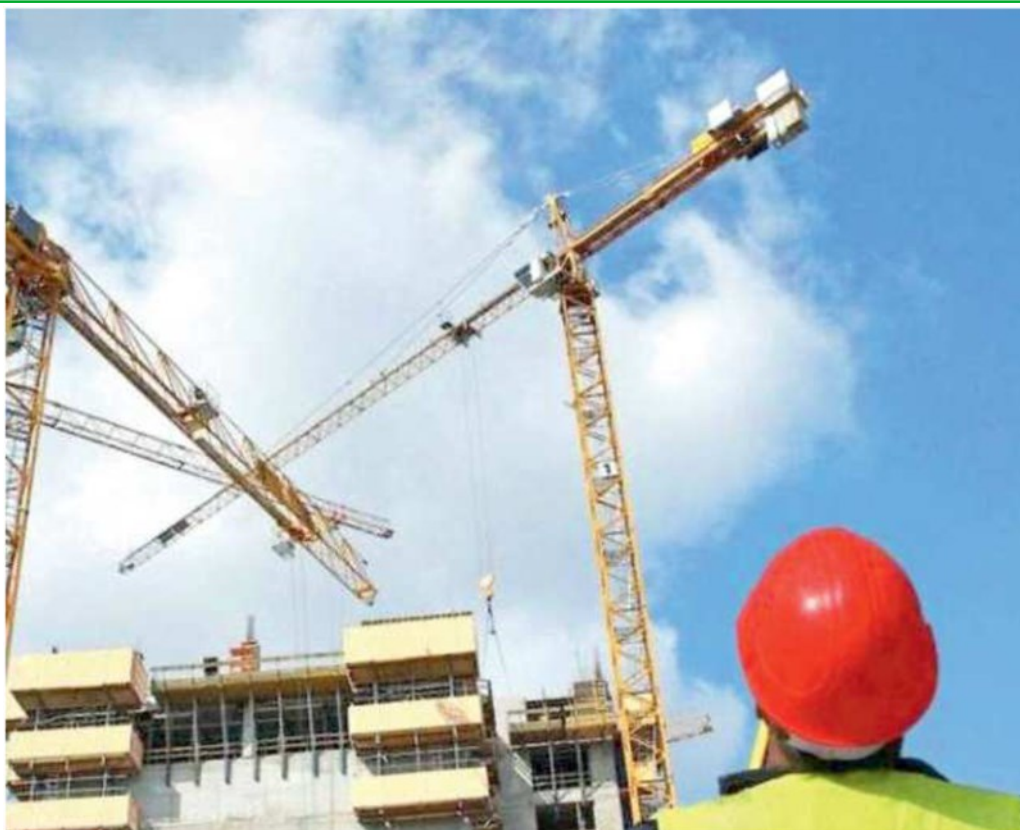
Un cantiere edile
