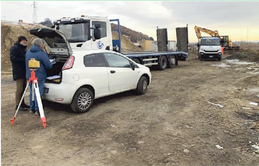
Il cantiere per la nuova scuola a Calcinaia
