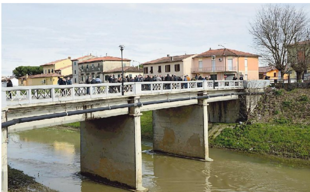
Il ponte di Montecalvoli sul canale Usciana
