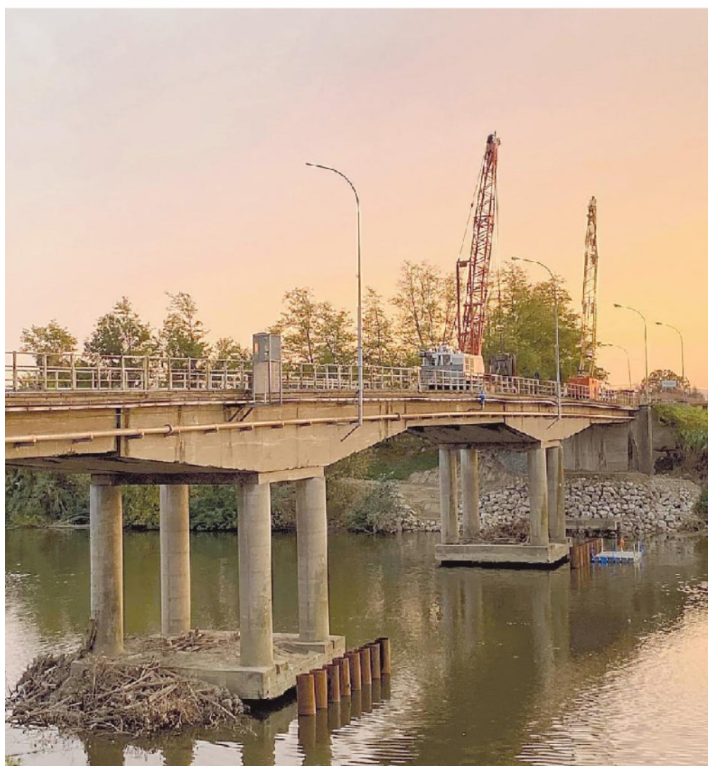
avori al ponte sull'Arno in via papa Giovanni XXIII a Calcinaia
