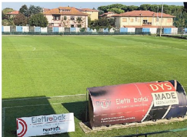
Uno degli impianti di Fornacette
