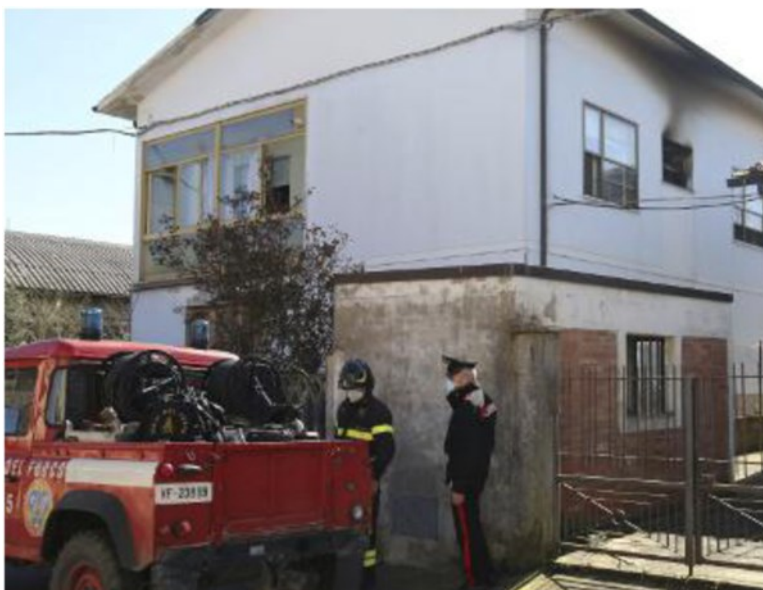
L'abitazione danneggiata dalle fiamme
