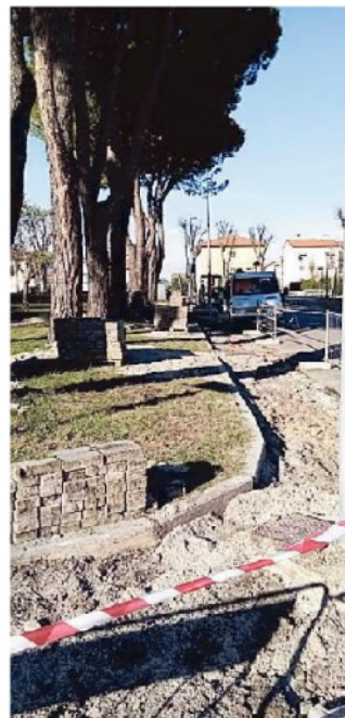
Lavori in piazza Fermi
