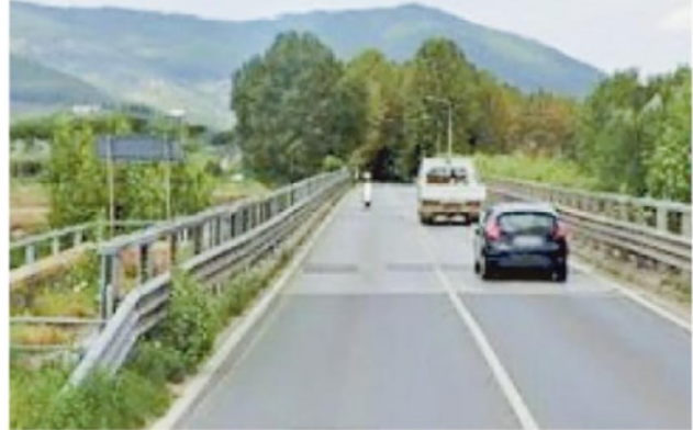
Il ponte sulla strada provinciale 1 tra i Comuni di Vicopisano e Calcinaia
