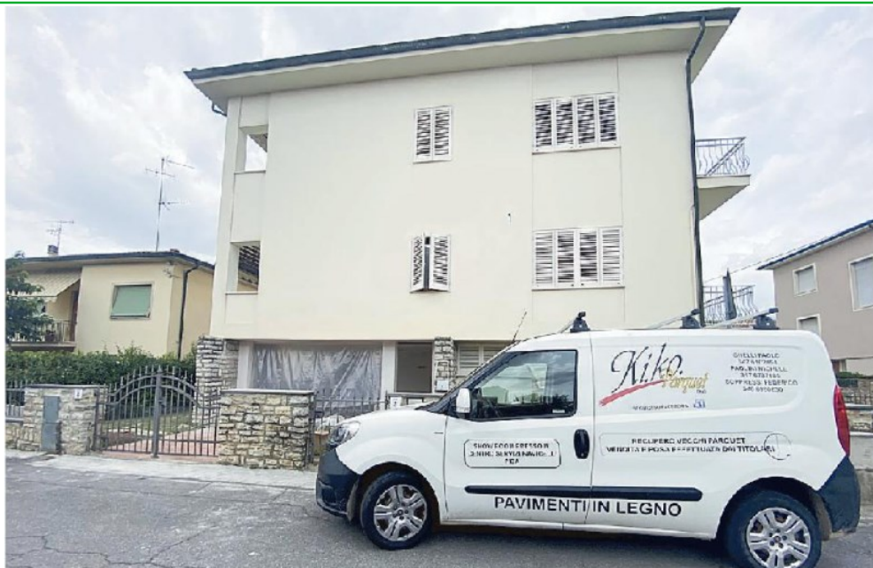
Il luogo dove si è verificato l'incidente sul lavoro
