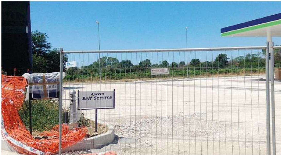
Il cantiere dei lavori per la costruzione del nuovo distributore lungo l'Arnaccio
