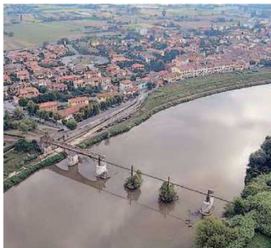
I RESTI Il ponte ferroviario di Calcinaia bombardato nella seconda guerra mondiale
