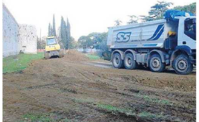
I lavori sotto le mura in via Veneto
