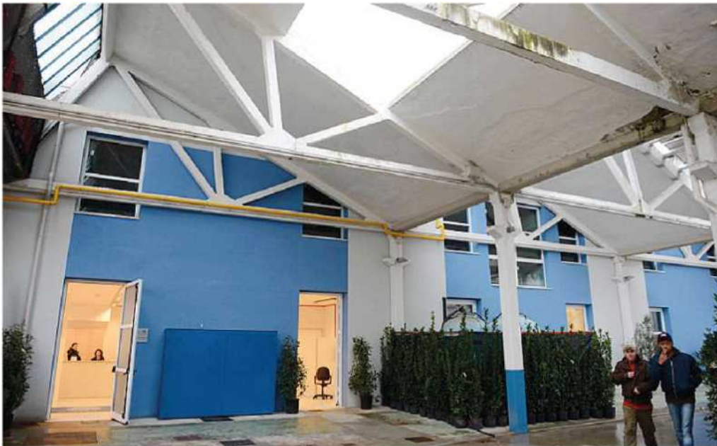
Uno scorcio del polo universitario di viale Piaggio a Pontedera (foto Franco Silvi)
