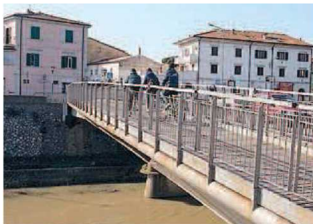
LIFTING La passerella pedonale di Fornacette si fa il taglio il prossimo giovedì 3 ottobre
