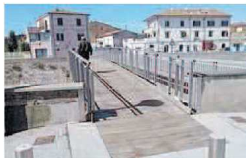
CANTIERE Nei prossimi giorni al via i lavori. Saranno spesi 40mila euro
