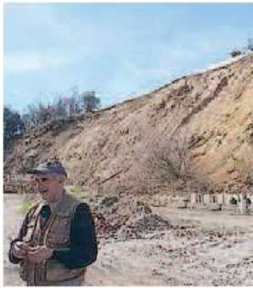
MALCONTENTO Vincenzo Campareri davanti alla frana
