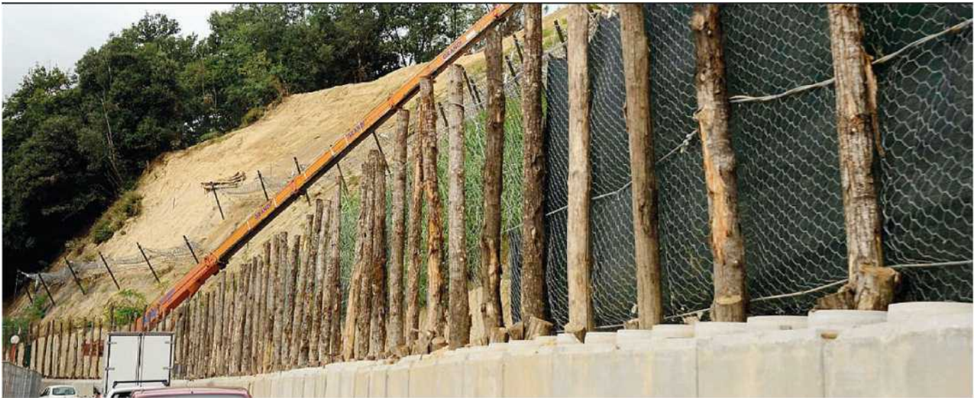
Qui l'opera di palificazione per contenere la frana in basso, sotto una veduta ampia del fronte franoso, nelle foto piccole l'assessore provinciale Santoni e operai al lavoro sulla collina
