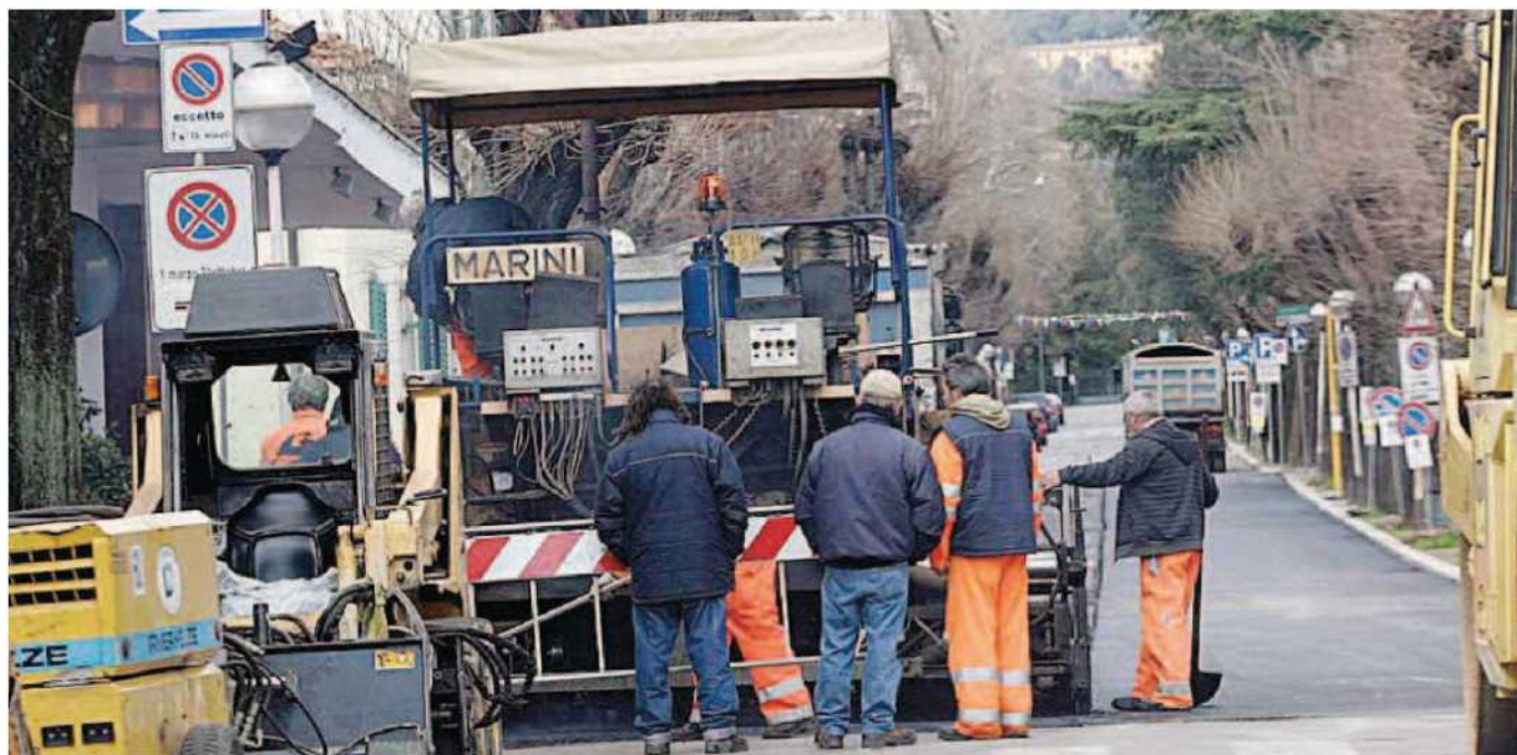
Un'impresa al lavoro per la nuova asfaltatura di un tratto di strada
