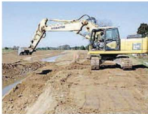
Uno dei cantieri lungo i corsi d'acqua della provincia che servono a rendere più sicuro il territorio e a scongiurare il rischio delle alluvioni: la Provincia ha messo in conto 3,5 milioni di euro
