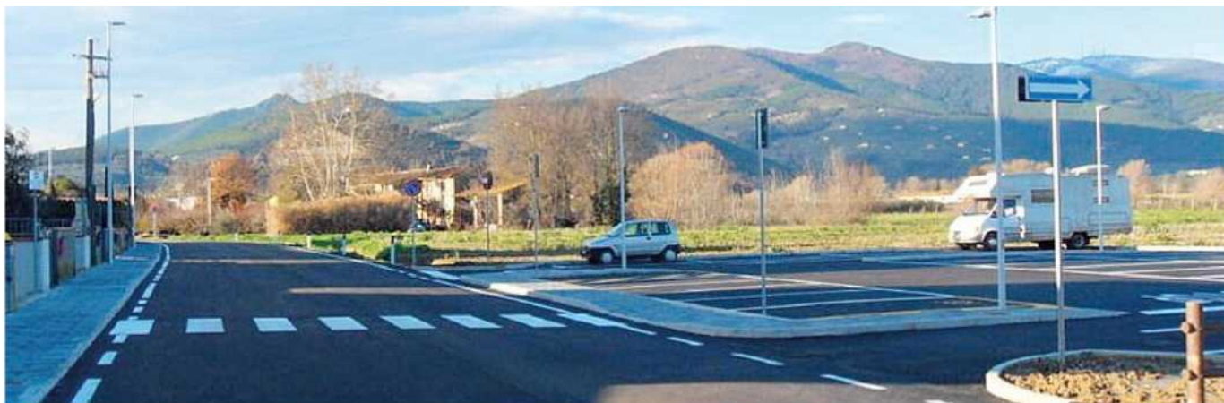
Un tratto della strada realizzata nella frazione di Fornacette nella zona delle Case Bianche
