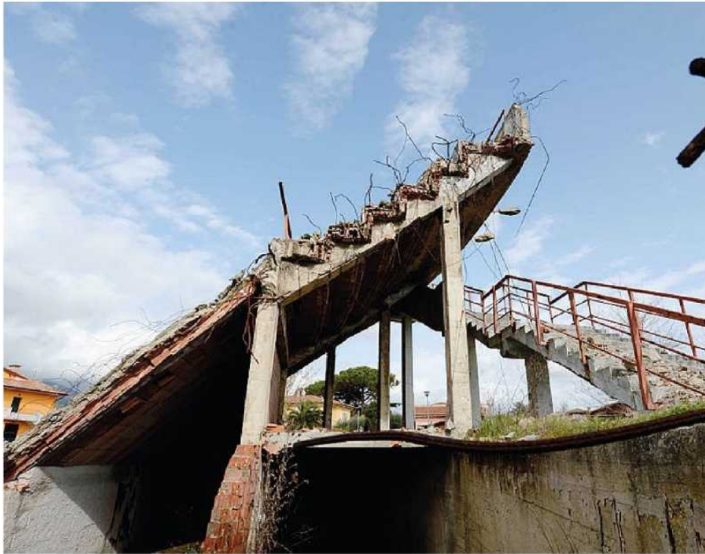
Una parte della pista dell'ex Velodromo rimasta intatta dopo la demolizione (Foto Silvi)
