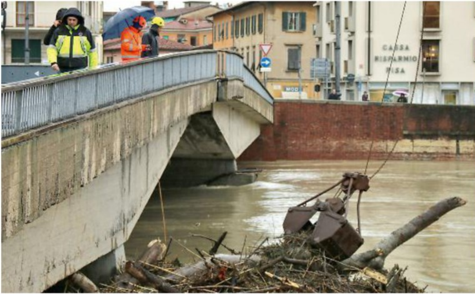
La rimozione dei detriti accumulatisi sotto il ponte dopo la piena dell'Arno (foto Valtriani)
