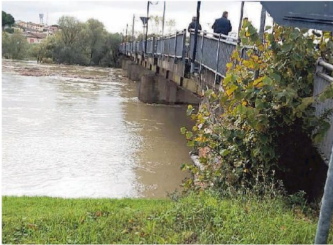
Il ponte sul fiume a Castelfranco di Sotto
