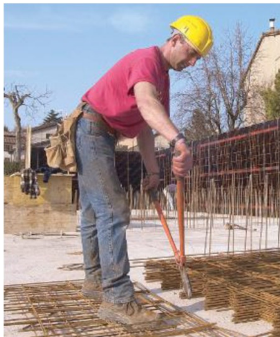
CANTIERE IN VISTA Passo in avanti per la futura palestra
