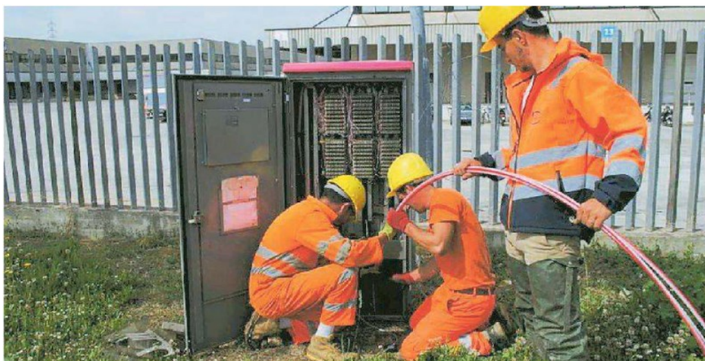
Operai di Tim al lavoro per l'installazione dei cavi per la fibra (FOTO D'ARCHIVIO)
