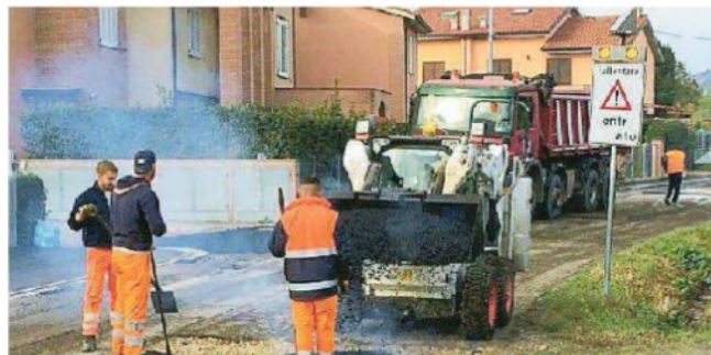
Lavori in corso nella zona di Case Bianche
