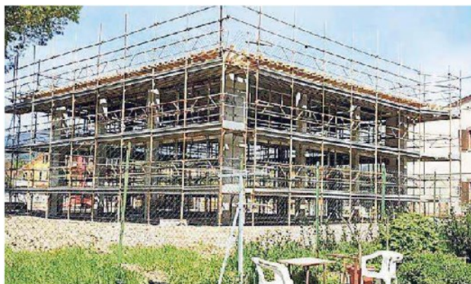
Il cantiere nell'area dell'ex velodromo di Fornacette
