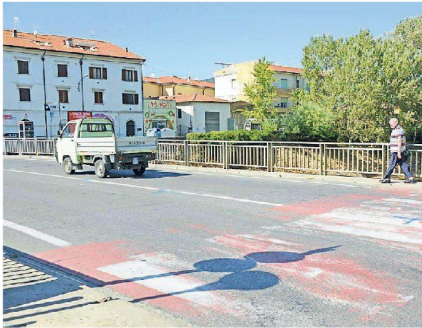
Il ponte sul canale Emissario a Fornacette dove saranno realizzati lavori di manutenzione straordinaria (Foto Franco Silvi)
