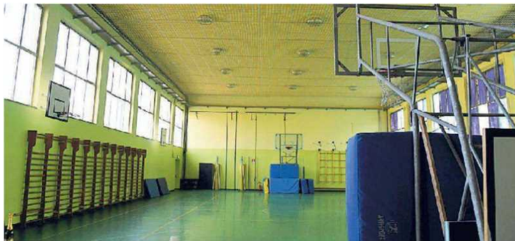
La palestra dell'Ictg Fermi di Pontedera dopo i lavori di manutenzione straordinaria (Foto Franco Silvi)
