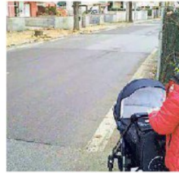
Assenza di strisce pedonali
