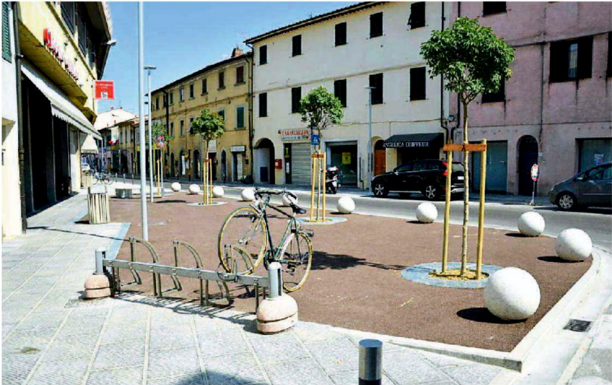
I lavori di riqualificazione appena conclusi a Fornacette
