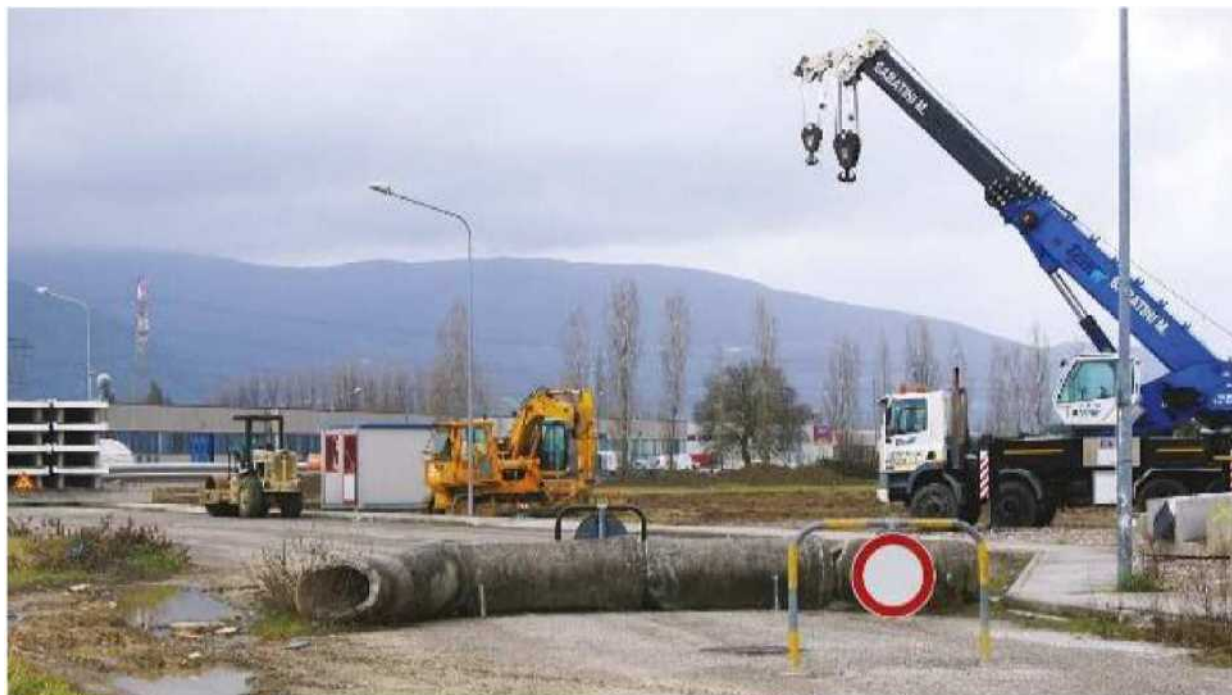
CANTIERE La strada della discordia che aprirà in estate
