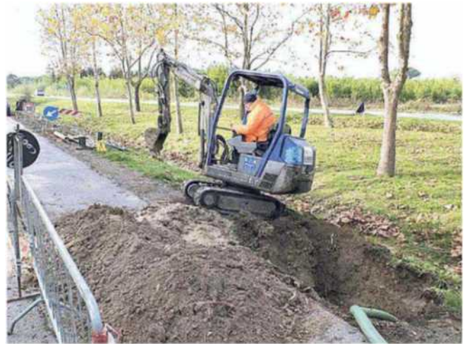
Si lavora per eliminare una perdita d'acqua (Foto d'archivio)
