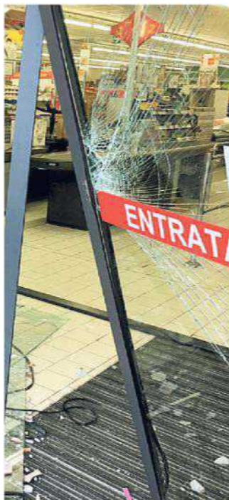
Danni causati dai ladri
