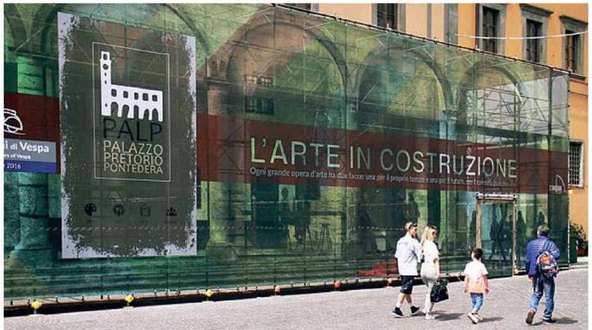
SIMBOLO DELLA VALDERA Lavori in corso al palazzo pretorio, in pieno centro a Pontedera
