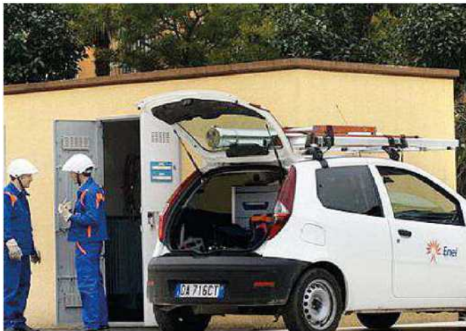
Operai dell'Enel durante dei lavori ad una cabina (foto di repertorio)
