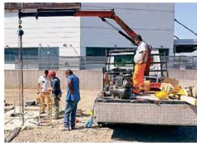
IN CORSO Gli operai che, proprio in queste ore, stanno completando i lavori
