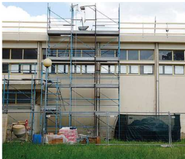
Il cantiere (Foto di repertorio)
