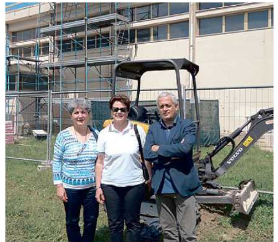
IL CANTIERE Il sindaco Lucia Ciampi, l'assessore all'istruzione Maria Ceccarelli e il direttore dei lavori, Alfredo Alunni Macerini
