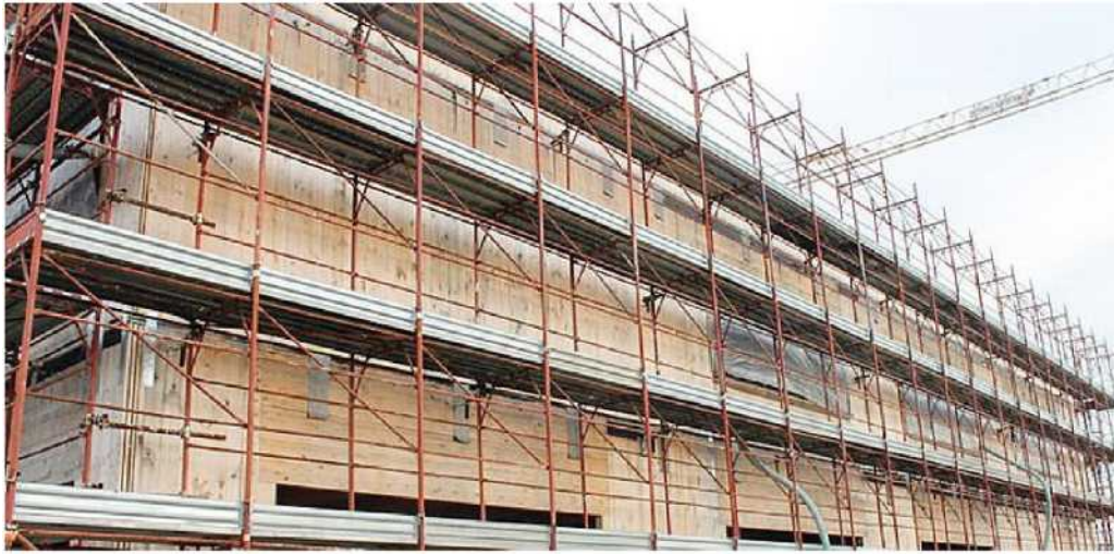
Il cantiere della scuola a Fornacette
