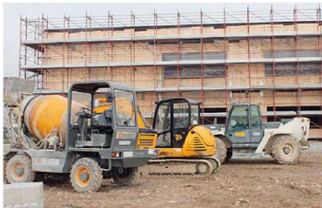
Il cantiere per la costruzione della scuola a Fornacette
