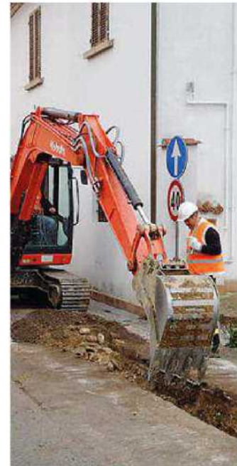
Il cantiere dei lavori
