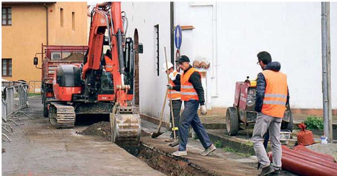
CANTIERE APERTO I lavori nel centro storico di Calcinaia per le nuove fogne
