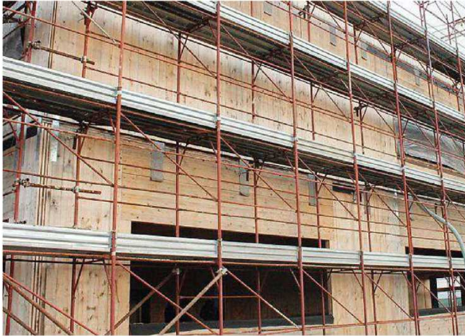
Il cantiere della nuova scuola elementare in via Morandi a Fornacette
