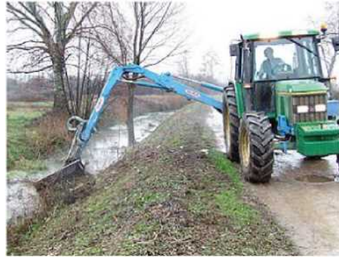
Lavori di pulizia lungo l'argine di un canale da parte del Consorzio di bonifica (foto d'archivio)
