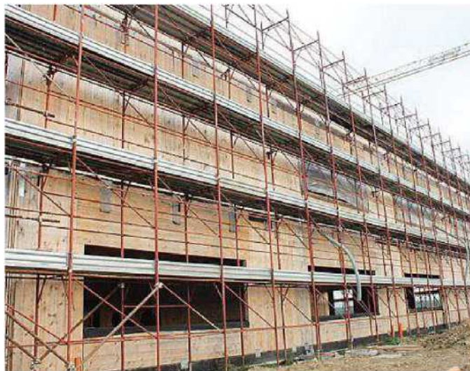
La scuola in costruzione a Fornacette
