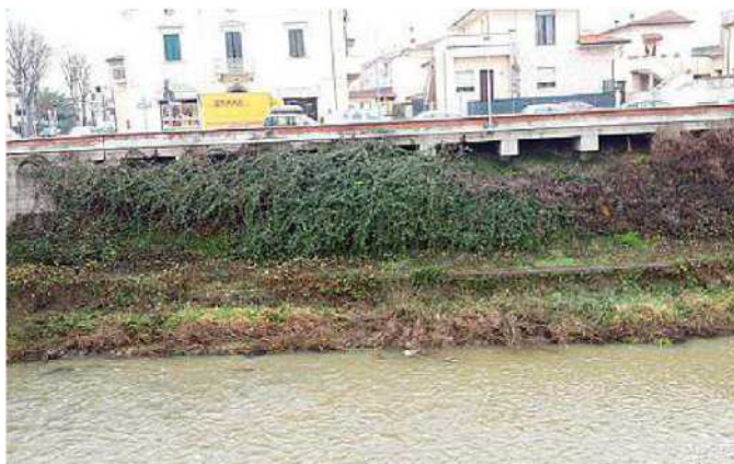
Le sponde del Canale Emissario pulite dal Comune
